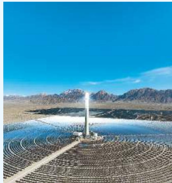
地处柴达木盆地的青海省海西蒙古族藏族自治州德令哈市依托丰富的光照资源、广阔的土地资源，制定新能源产业布局，加速推进大型光伏、光热基地建设，清洁能源产业集群不断壮大，进一步推动柴达木盆地经济发展绿色转型。图为近日在德令哈市光伏（光热）产业园拍摄的光热电站。 新华社记者 张 龙摄
