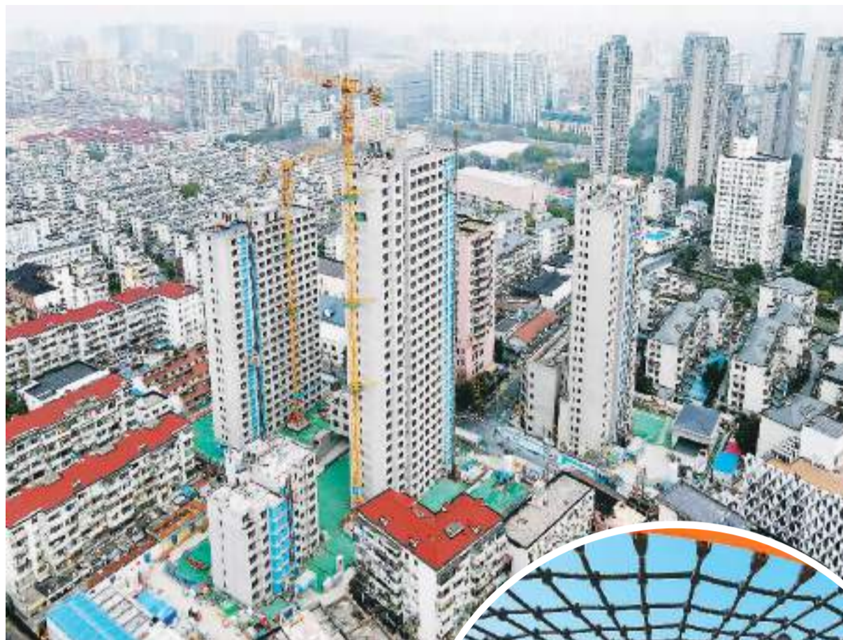
近日，上海市静安区谈家桥城市更新项目施工现场正在稳步推进。图为项目施工现场。新华社记者方喆摄
