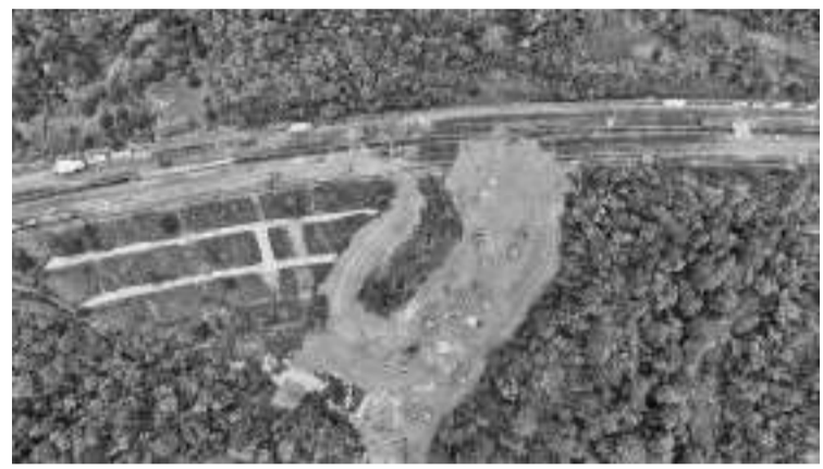
5月2日拍摄的广东梅大高速茶阳路段塌方灾害现场(无人机照片)。
