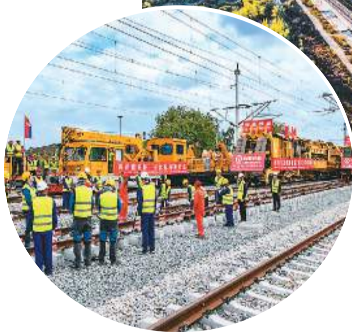
4月25日，在塞尔维亚北部城市巴奇托波拉，匈塞铁路项目施工人员进行匈塞铁路轨道合龙工作。
