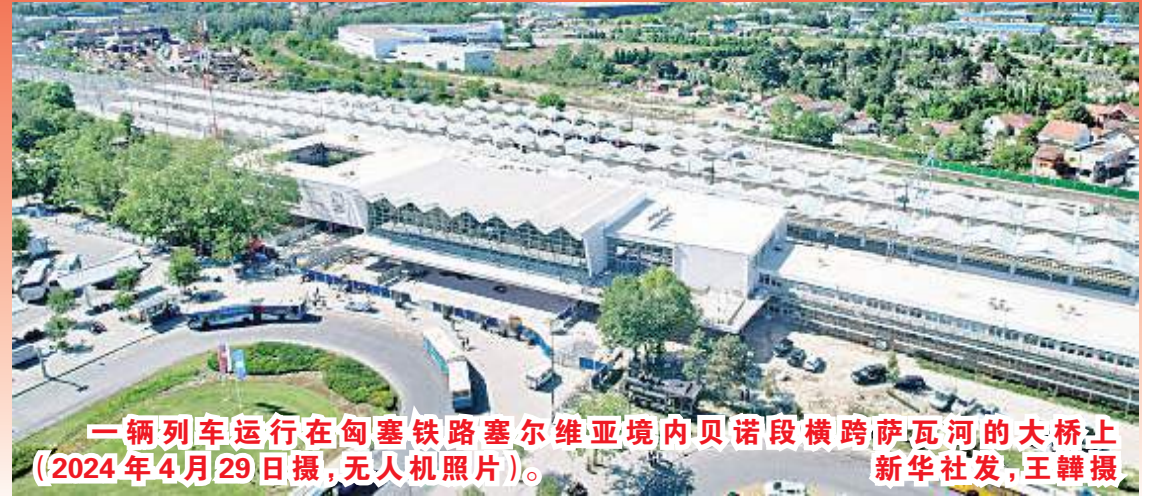
一辆列车运行在匈塞铁路塞尔维亚境内贝诺段横跨萨瓦河的大桥上(2024年4月29日摄,无人机照片)。新华社发,王轶摄
