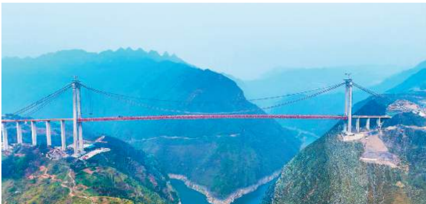
4月28日,纳(雍)晴(隆)高速纳晴江大桥正式合龙。纳晴江大桥位于贵州省晴隆县和普安县交界处,大桥全长1849米,主跨1080米,桥面至江面最高距离380米。大桥的合龙,为纳晴高速全线建成通车打下坚实基础。图为纳晴江大桥。 史志鹏、黄益摄影报道
