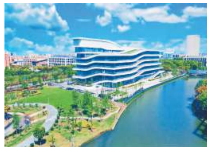
上海临港青少年活动中心日前竣工。该项目由中建八局一公司承建，总建筑面积约6.1万平方米，为临港新片区重点民生工程、临港教育改革开放先行区重点项目、临港三大地标性建筑之一，融汇“三全五育”和“STEAM”教育理念，定位为“科艺方舟 创梦未来”青少年梦想启航点，将有力促进上海青少年的全面发展。冉一帆摄（人民视觉）
