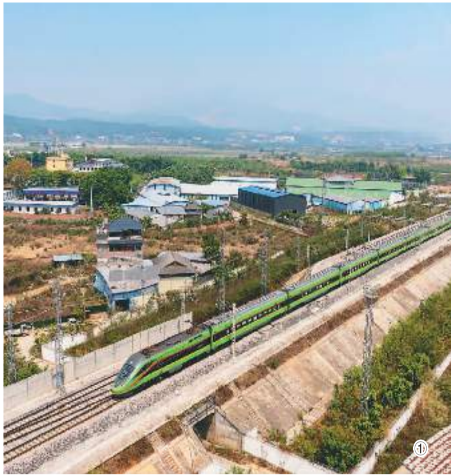
图①：“五一”期间，中老铁路客流增长明显。图为5月1日，云南省西双版纳傣族自治州景洪市，云南昆明开往老挝万象的国际旅客列车缓缓驶出西双版纳站。
